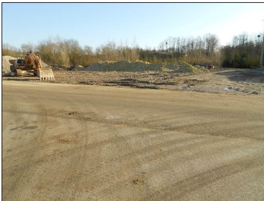
Le terrain actuel accueillant la plate-forme sert de stockage temporaire d'inerte
