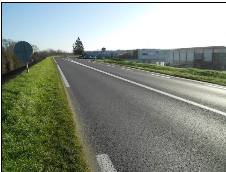
L'accès VL par la RD 751 est protégé par une voie de décélération. En venant de l'est, il est interdit de couper la voie.
